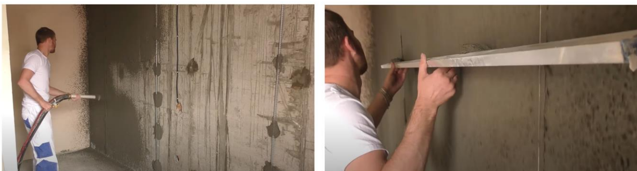
Рис. 23. Схема нанесения обрызга на поверхность и разравнивание правилами образовавшихся наплывов
