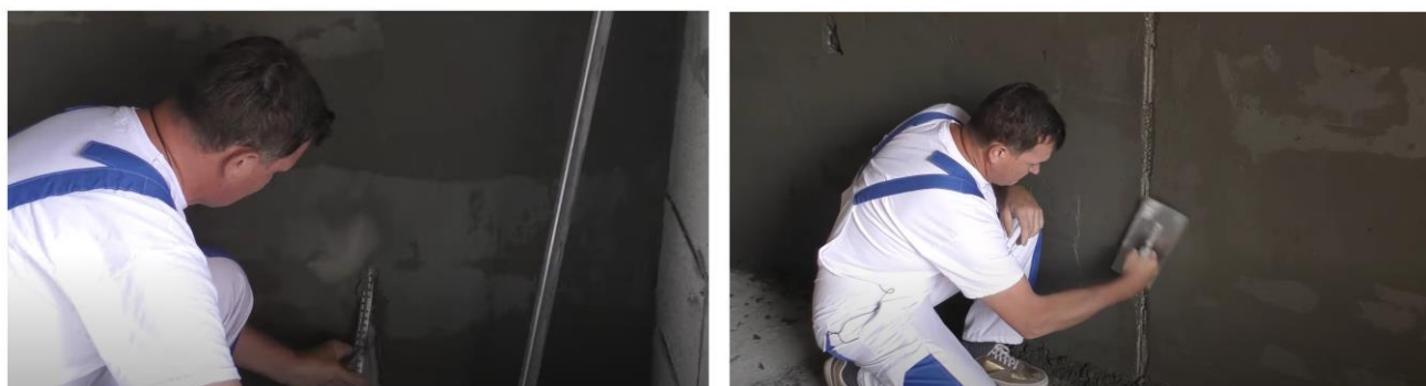
Рис. 25. Схема демонтажа маяков и заделки образовавшихся борозд
